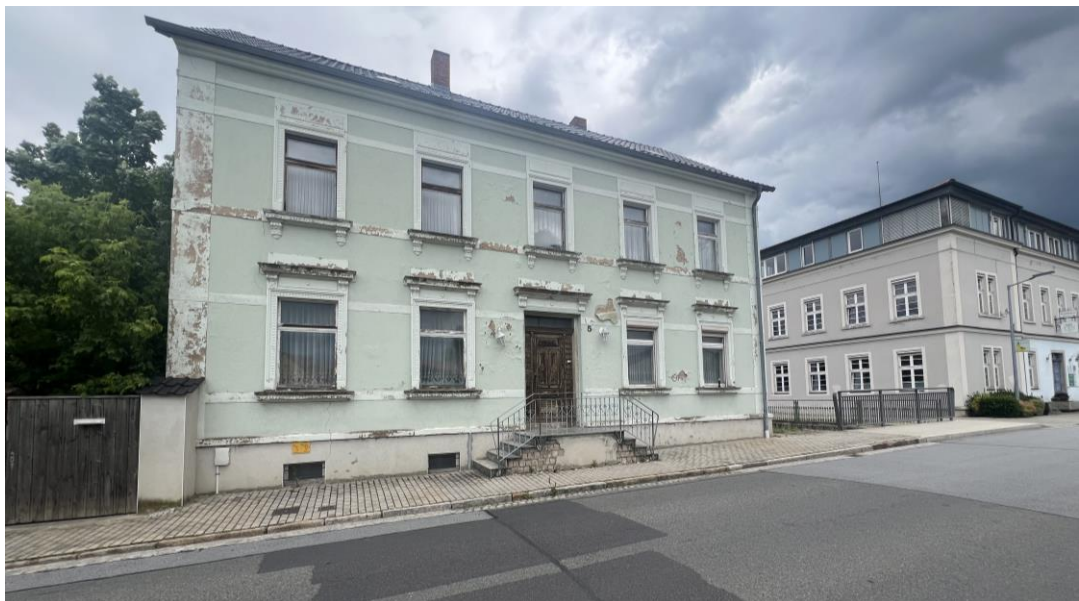
Abbildung 23: Eine sanierungsbedürftige Immobilie im Ortskern von Königswartha
