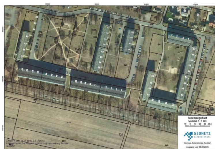
Abb. 7: Rückbauflächen Neubaugebiet an der Hahnebergstraße / Kastanienring (Geonetz-Datendienste Bautzen, Februar 2026)
