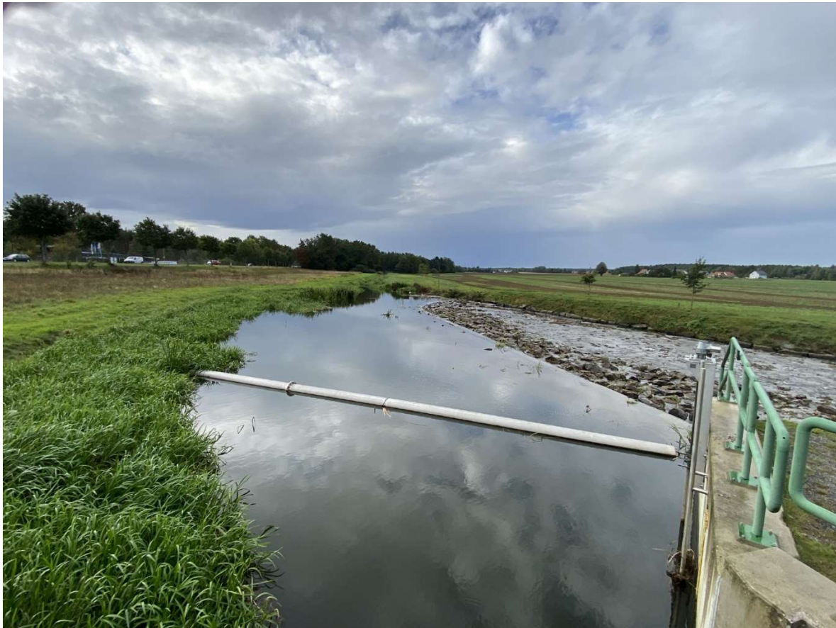
Abb. 2: Aufweitung des Gewässers im Bereich des Niesendorfer Wehres mit Fischaufstiegsanlage
