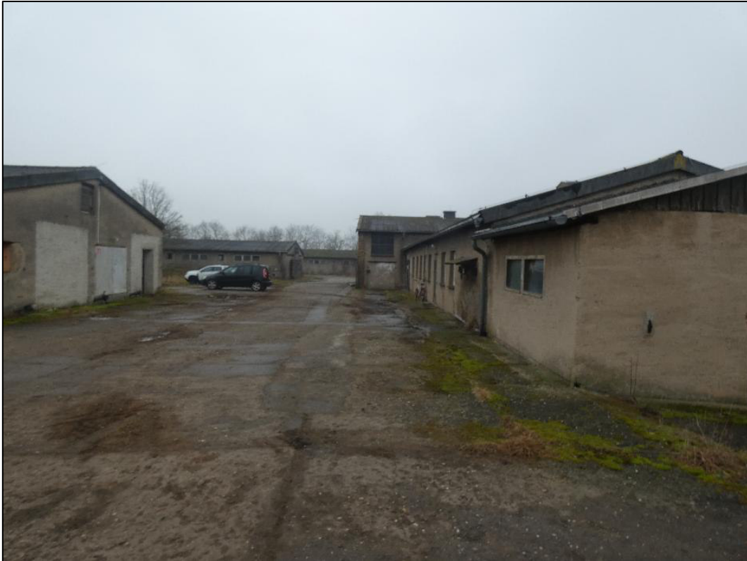
Abbildung 3: Blick auf Gebäudekomplex im Westen der Fläche
