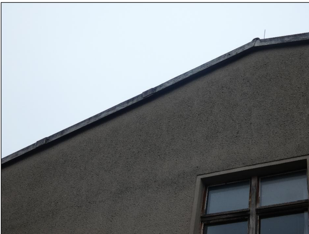
Abbildung 14: Potentielle Quartierstrukturen für Fledermäuse
