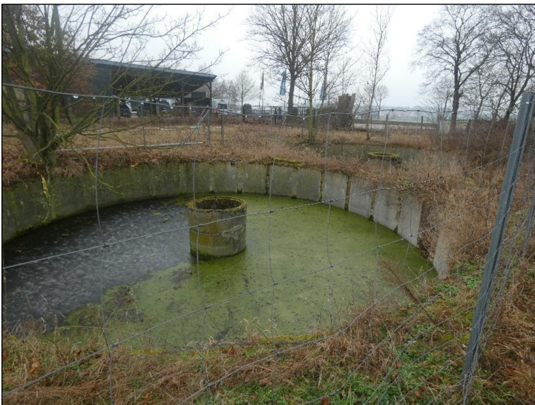
Abbildung 10: Ehemaliges Absatzbecken der Kläranlage
