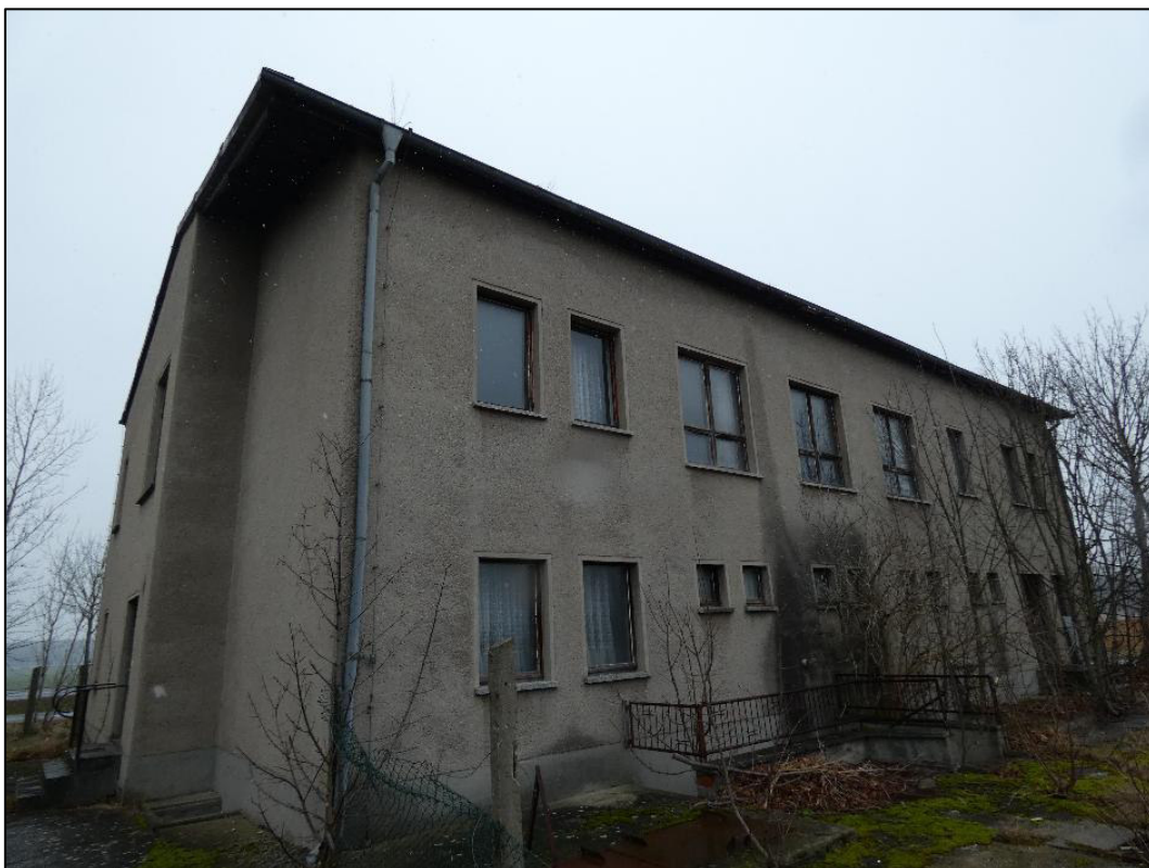
Abbildung 2: Ehemaliges Verwaltungsgebäude im Westen der Fläche
