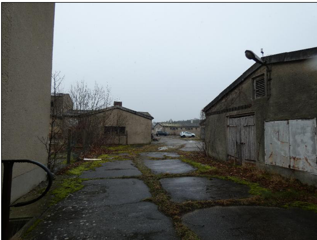
Abbildung 1: Blick auf die ehemalige Schweinemastanlage in Richtung Osten
