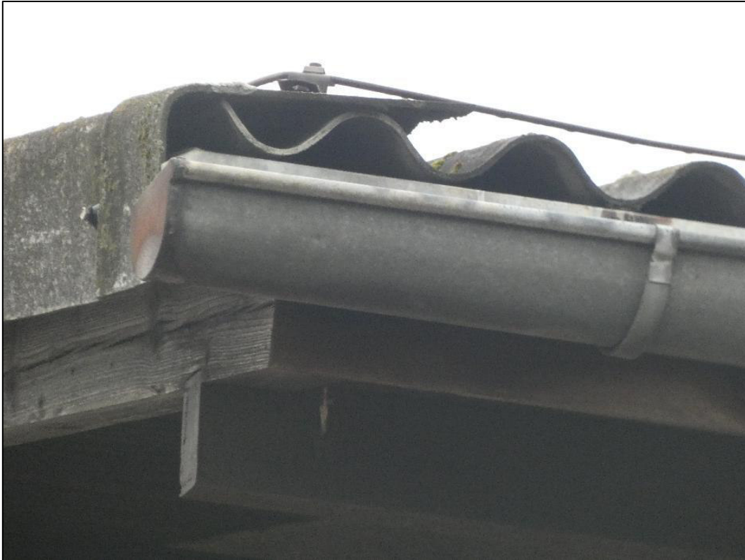
Abbildung 15: Potentielle Quartierstrukturen für Fledermäuse
