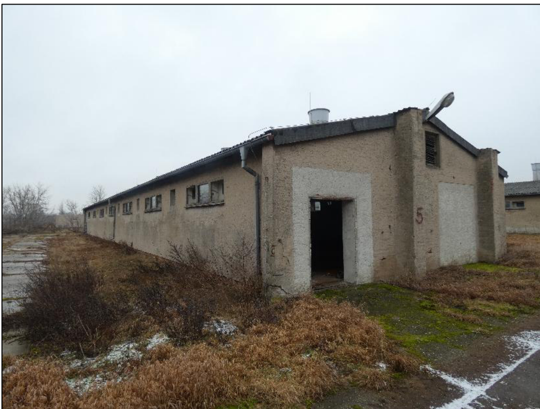
Abbildung 12: Stallung der ehemaligen Schweinemastanlage
