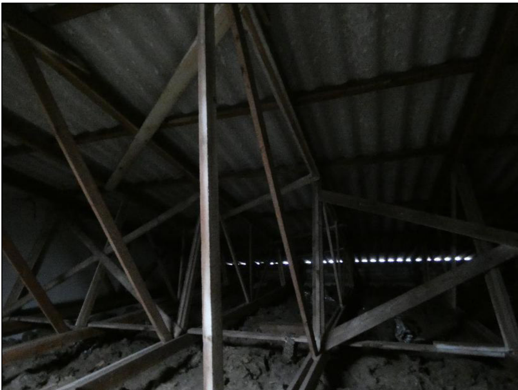
Abbildung 16: Dachbereiche mit offenen Strukturen
